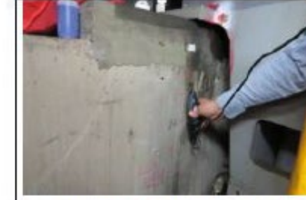
Şekil 7. Yapıştırma yüzeylerinin temizlenmesi
